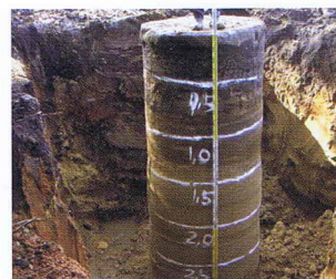
● 掘り出し調査
